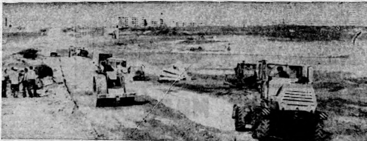
На строительстве путепровода отлично работает экскаваторщик СМУ - 7 УСМР А. Н. Крылов.
